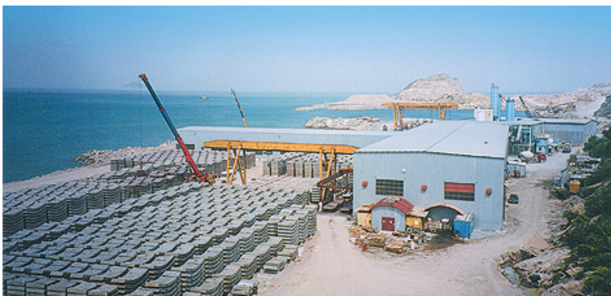
中國珠海牛頭島混凝土預制件廠近貌
