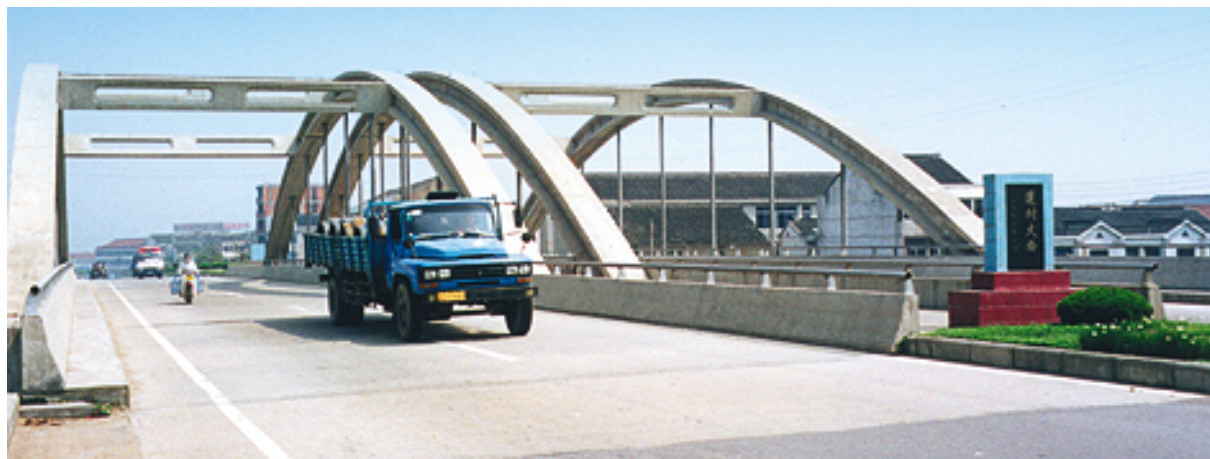
中國江蘇省省道 211 常州至漕橋公路主橋運村橋
